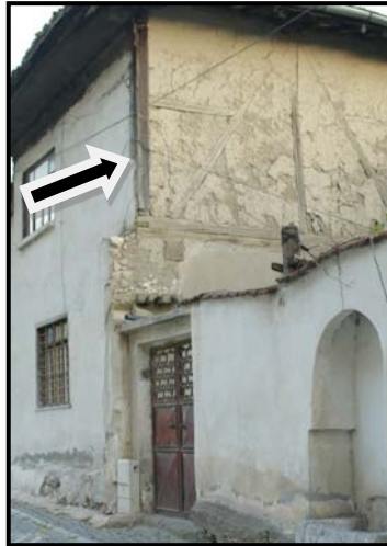
Şekil 34. Çalışma alanındaki bir konutun malzemesi
