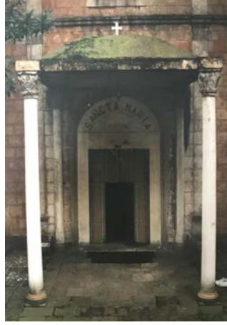
Foto.8. Batı cephe, detay
