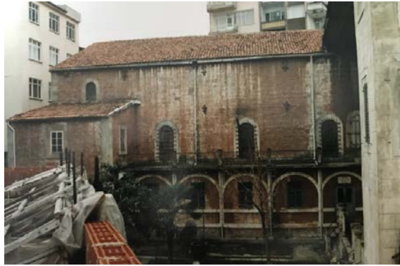
Foto.5. Kilisenin kuzey cephesi
