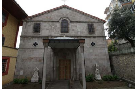
Foto.7. Kilisenin batı cephesi
